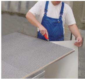
Durch die geschlossene, reißfeste Verbundschicht auf der Unterseite kann „BLACK-CAT“-Ultralight mit Verbundkaschierung vollflächig auf fast jedem Untergrund aufgeklebt, getackert oder vernietet werden. Für passgenauen Zuschnitt wird „BLACK-CAT“-Ultralight mit Verbundkaschierung einfach mit dem Cutter abgetrennt.
